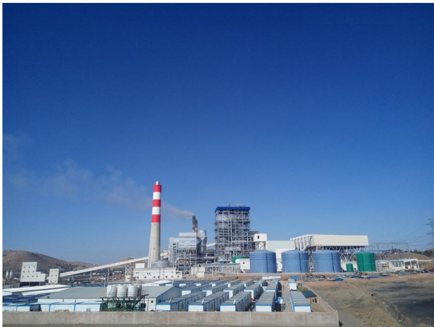
山东三建承建的杰拉达水电站项目
