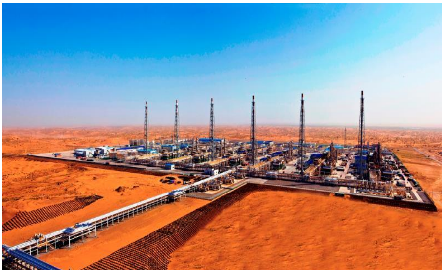
“复兴”气田一期第一天然气处理厂
