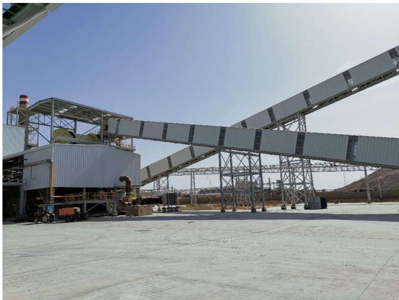
东华科技承建突尼斯化工集团项目
